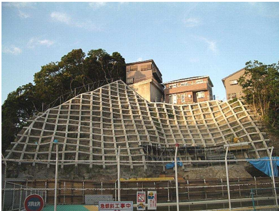
写真 1 崩壊した斜面を SH 型貫入試験で調査して対策工を施工した例
