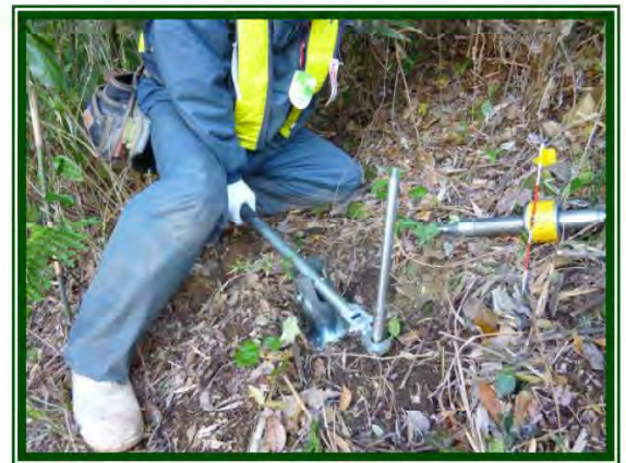
引抜き作業状況
